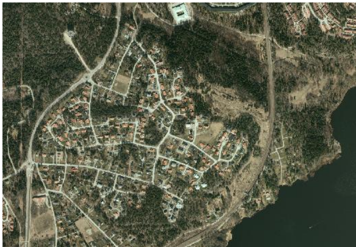
Bild 9. Järnvägsspår som löper genom område, längs med sjön Drevviken, med stabilitetsproblem.
